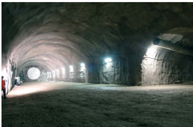
Obr.5 Inštalačná a prieskumná chodba
