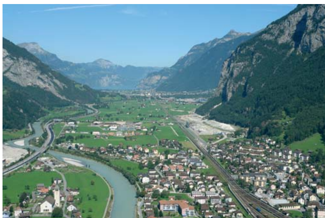
Obr.4 Stavenisko v Erstfelde
