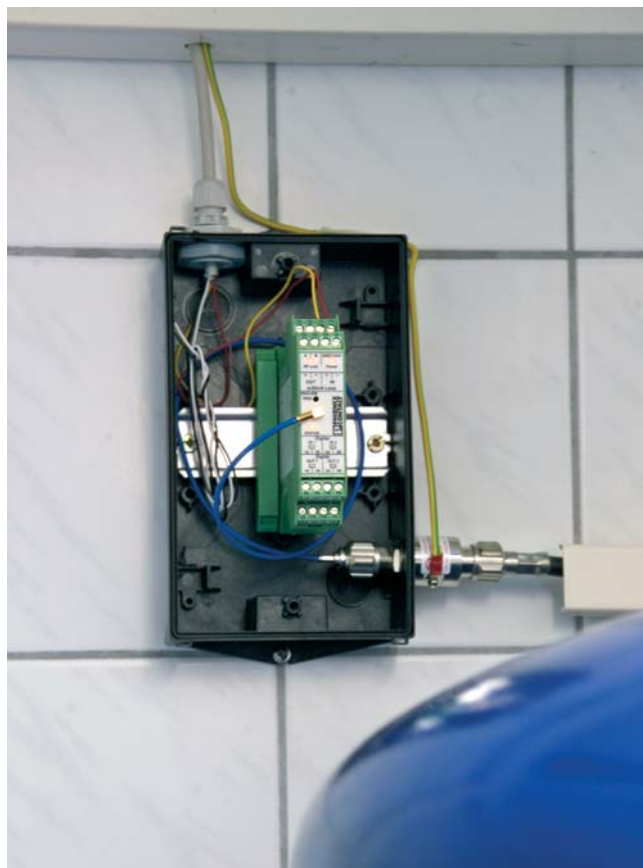
Obr.2 Opakovač (tretí obojsmerný rádiový prijímač) prekonáva v Molsheime neexistujúce priame prepojenie medzi Dalsheimom a Molsheimom – opakovanie posla signály v nezmenenej podobe
