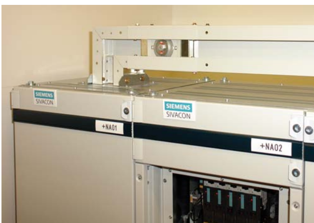
Pre najnovšiu generáciu nízkonapäťových rozvodní Siemens Sivacon S8, ako aj pre ďalšie modely existujú adaptéry na priame pripojenie prípojnic systému LX na hlavné prípojnice
