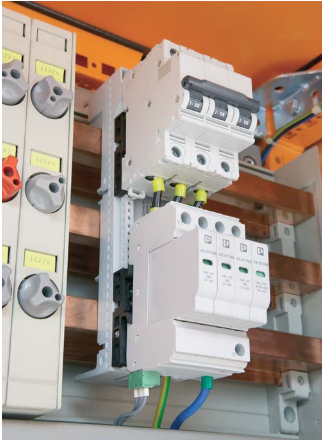
Obr.3 Kombinácia MOSO predstavuje prepäťovú ochranu so zabudovaným predradeným istením vo vyhotovení pre 60 mm koľajničku
