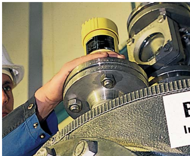
Obr.1 Montáž hladinoměru na nádoby pro skladování čpavku
