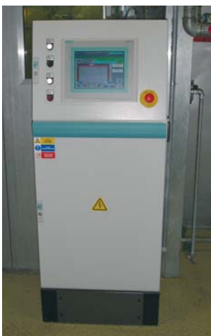
Riadiaci rozvádzač s modulom C7-636
