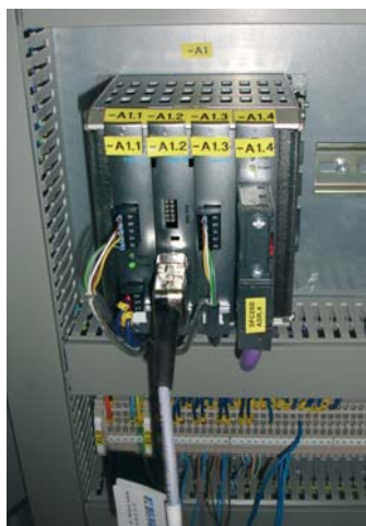
Riadiaca jednotka polohovacích valcov SPC200
