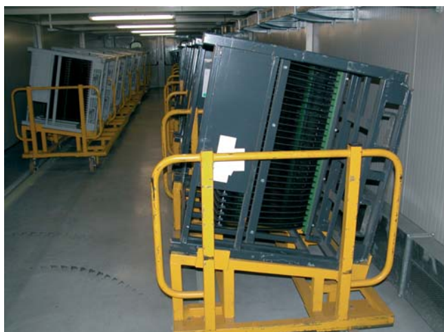
Pohľad do klimatizačnej komory
