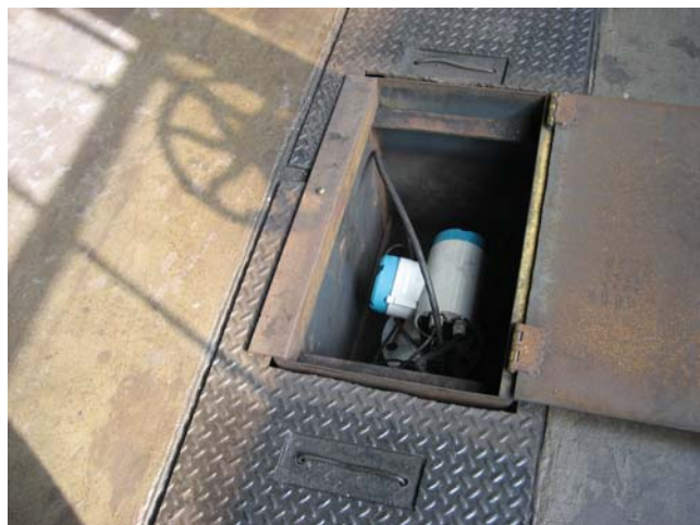
Uhoľná elektrárňa v USA používa na automatizáciu procesu plnenia zásobníkov uhlia systém so zavážacím vozíkom a meracím členom SITRANS LR460, ktorý meria výšku hladiny uhlia v každom zásobníku
