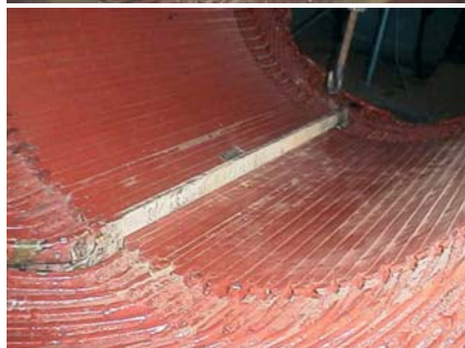
Obr.2 Možné poškodenia statora
