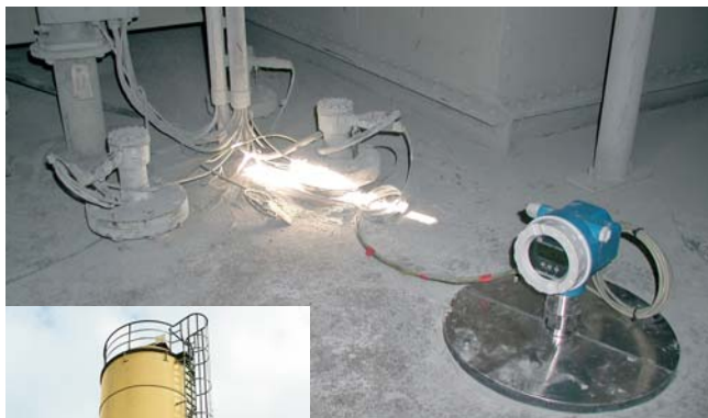
Obr.2 Meranie výšky hladiny vápna (extrémne prašné prostredie)
