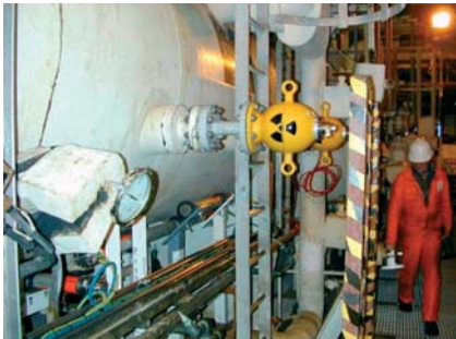
Obr.6 Meranie fázového rozhrania pomocou rádiometrického snímača Gammapiilot
