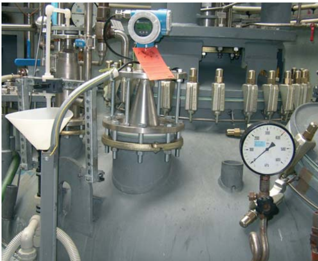
Obr.4 Micropilot M inštalovaný u farmaceutického výrobcu na Slovensku
