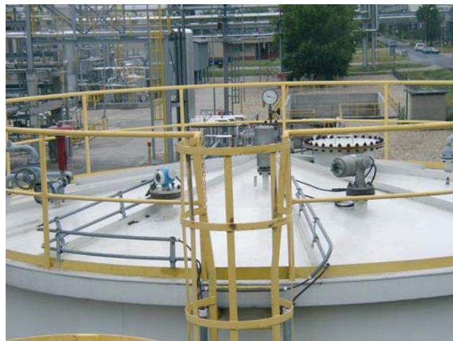
Obr.5 Micropilot M v petrochemickej výrobe na Slovensku
