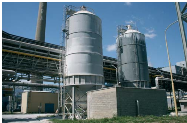
Pohľad na hlavné silá na nakupované vápno. Odtiaľ sa vápno pneumaticky prepravuje do malého sila umiestneného priamo nad hasnicou
