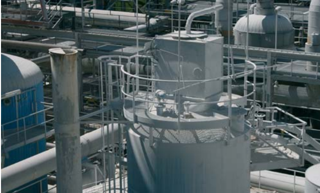
Pohľad na silo na nakupované vápno aj s prístrojom na meranie výšky hladiny v sile
