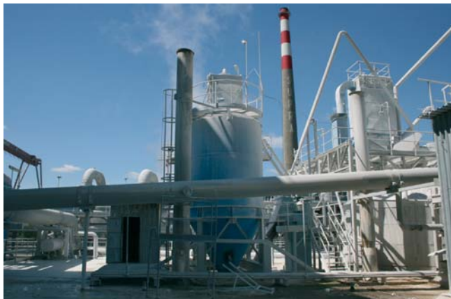
Pohľad na miesto aplikácie meracieho člena – silo na nakupované vápno umiestnené nad hasnicou
