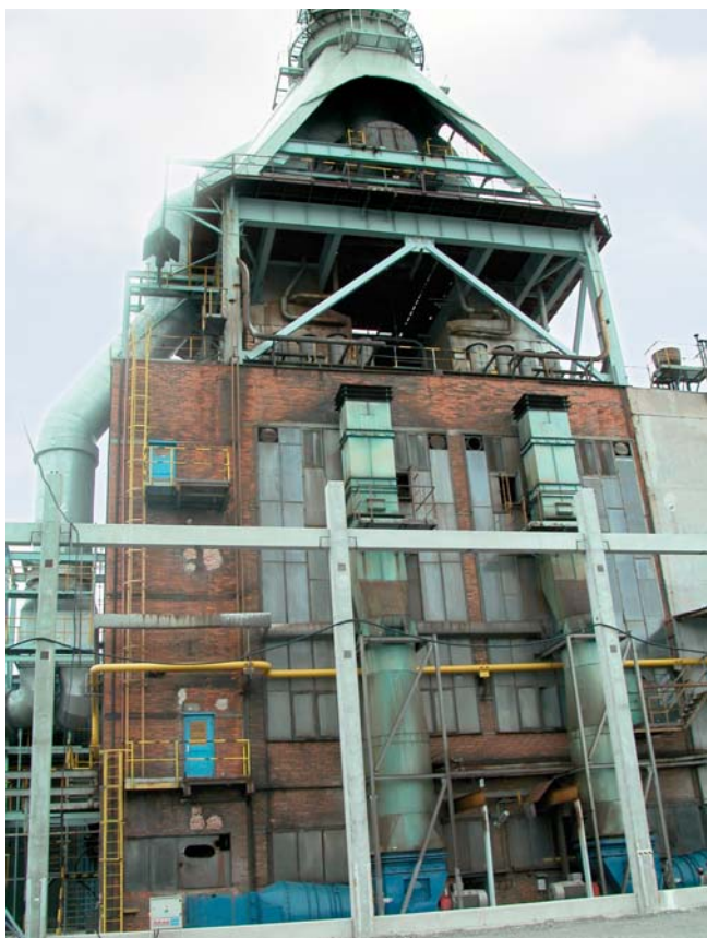
Celkový pohľad na severnú stenu kotolne pod komínom
