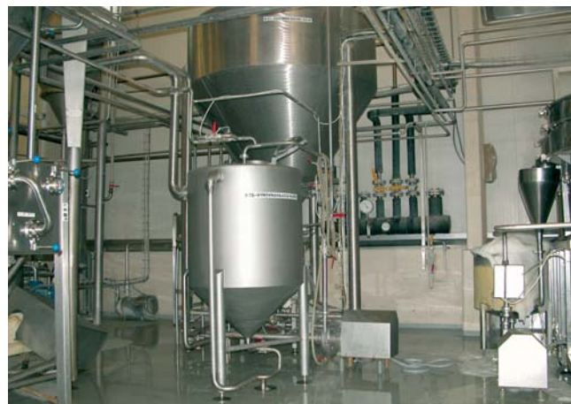
Silo na suchú sóju vybavené piezoelektrickou váhou a vodná prúdová doprava sóje
