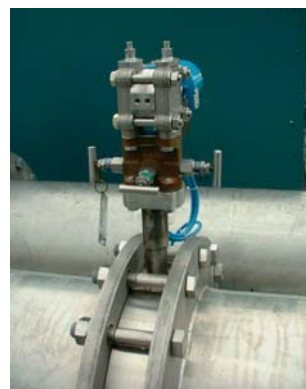
Kompaktné vyhotovenie prietokomera s rýchlostnou sondou, prevodníkom tlakovej diferencie a ventilovou súpravou
