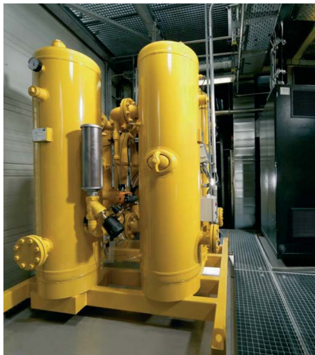
Na zamedzenie poškodenia systémov v rozvodoch stlačeného vzduchu vlhkosťou slúžia prevodníky monitorujúce sušičky
