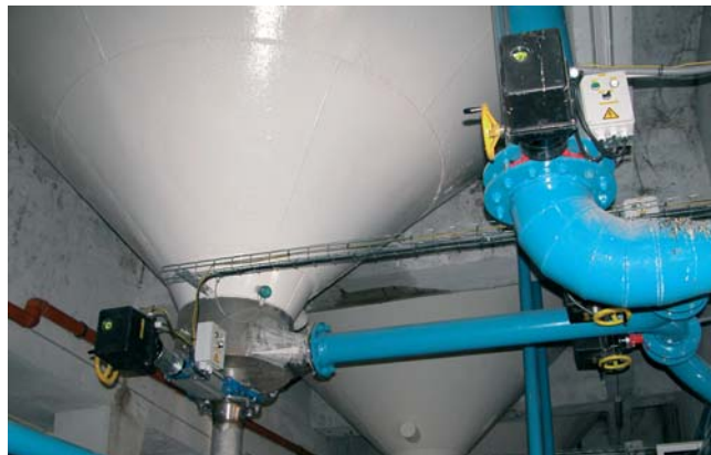
Šupátka a klapky so servopohonmi v priestore máčiarnie pod náduvníkmi
