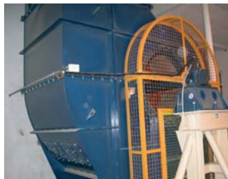
Ventilátor zabezpečujúci dopravu vzduchu z tepelného hospodárstva pod rošt hvozdu s meraním teploty ložísk a vibrácií
