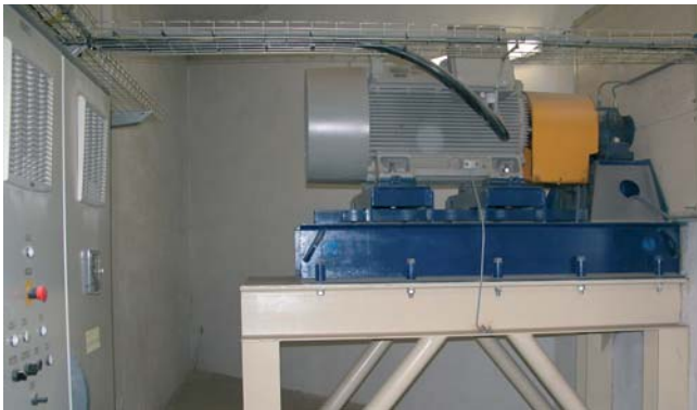
Motor s výkonom 160 kW so skriňou frekvenčného meniča pre pohon ventilátora tepelného hospodárstva
