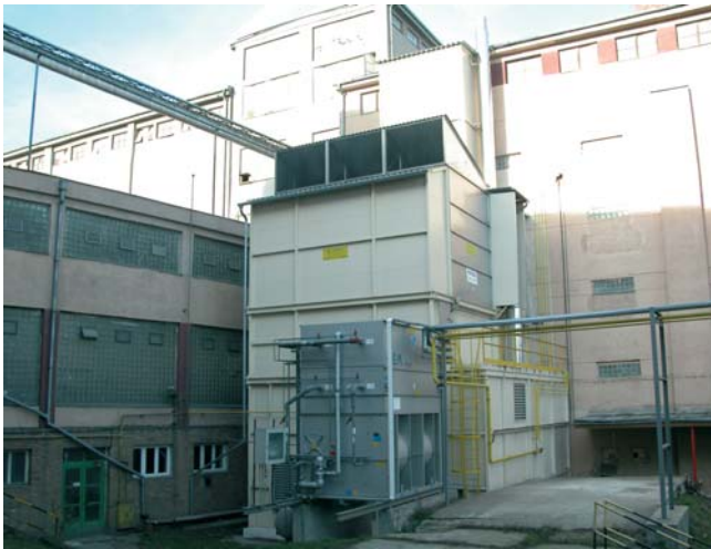
Pohľad na objekt tepelného hospodárstva
