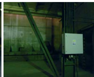
Kompletný rozvádzač s meničmi a výstavbou pre posuv EBT brány
