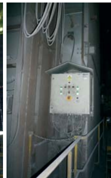
Kompletný rozvádzač s meničmi a výstavbou
