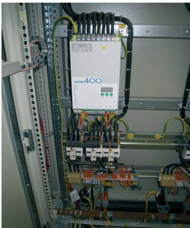
Softštartér inštalovaný v rozvádzači
