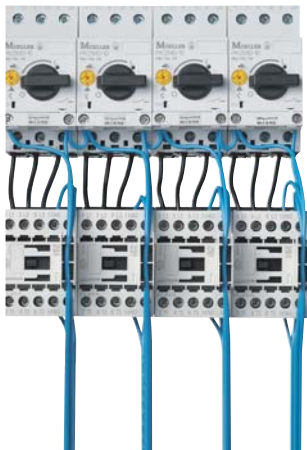
Obr. 1: Klasický spôsob inštalácie spúšťačových kombinácií
