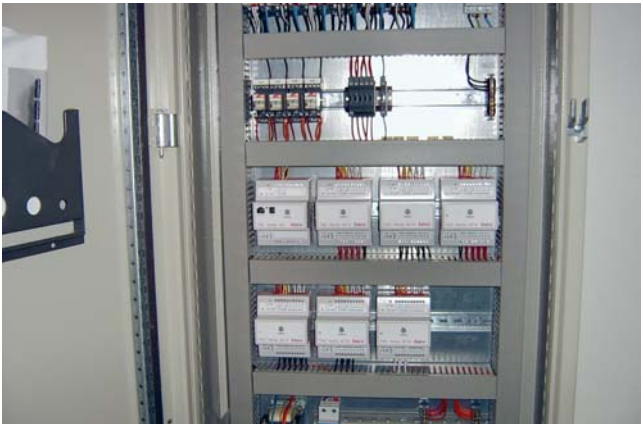
Pohľad na rozvádzač s riadiacim systémom ovládania technológie výroby chladu
