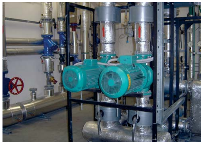
Technológia stanice odovzdávania tepla, konkrétne hlavné obehové čerpadlá ústredného kúrenia v objekte
