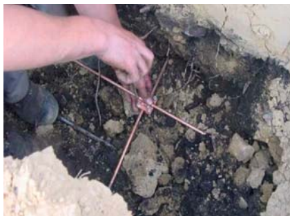
Obr.4 Vodiče uzemňovacej sústavy sú uložené v nezamrzajúcej hĺbke. Spojie pod zemou sú ošetrené proti korózii
