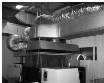
Řešení přívodu vzduchu do prostoru automatu, pružné hadice jsou odtahy
