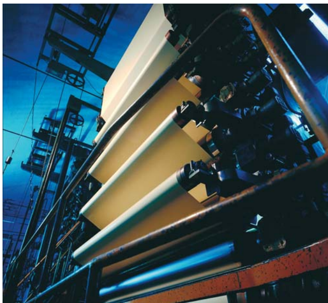
Vyhľadzovacie, prítlačné a vákuové valce, navijáčky či meniace sa strojové rýchlosti vyžadujú adaptívne monitorovanie postavené na vzniku udalostí
