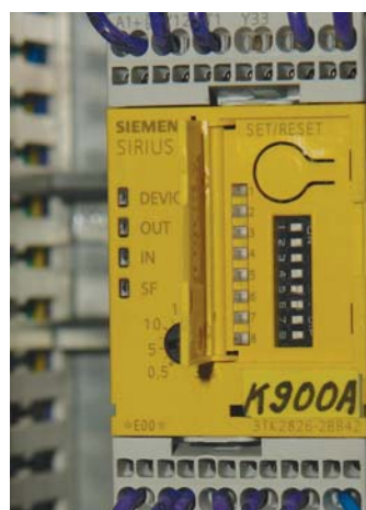
Bezpečnostné relé Sirius 3TK2826 má osem prepínačov DIP, ktoré umožňujú prispôbienie konfigurácie prístroja požiadavkám stroja a používateľa
