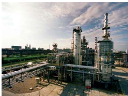
Odsírovanie polotovaru na výrobu motorovej nafty – výrobná jednotka HRP7 v Slovnafte
