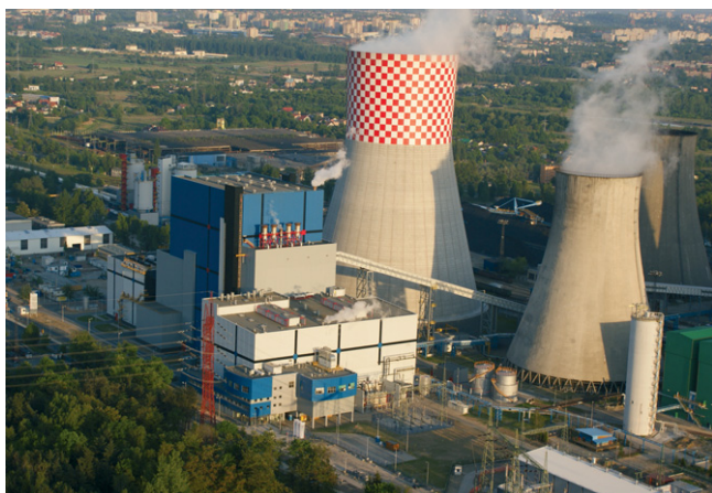
Obr.1 Nový blok elektrárne PKE Elektrowina Lagisza
