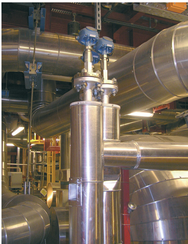
Obr.4 Radarové snímače hladiny Rosemount na vysokotlakovom ohrievači
