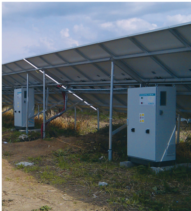
Obr. K optimalizácii FVE výrazne prispieva aj umiestnenie invertorov, napr. umiestnenie pod panely vytvára ich ochranu pred prehrievaním priamym slnkom alebo pred snehom.
