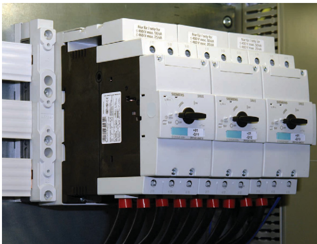
Obr. Zabezpečenie proti preťaženiu a skratu jednotlivých skupín kompaktných motorických vývodov preberajú motorické ističe Siemens Sirius 3RV.
