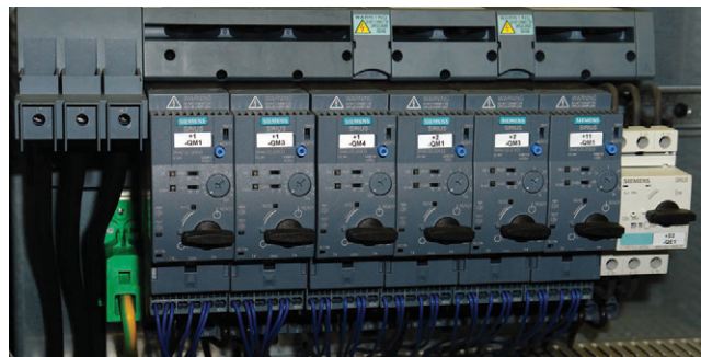
Obr. Dodávateľ výrobných zariadení August Elektrotechnik GmbH použil prvýkrát v zariadení na výrobu gumených tesniacich prvkov kompaktné motorické vývody Siemens Sirius 3RA6 a má s nimi pozitívne skúsenosti.
