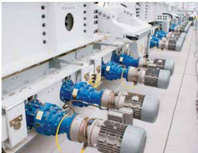
Obr. 1: 128 motorov, ka' d'ý s výkonom 5,6 kW, poháda za' ahovate'áne strešné panely (foto: Uni-System).
