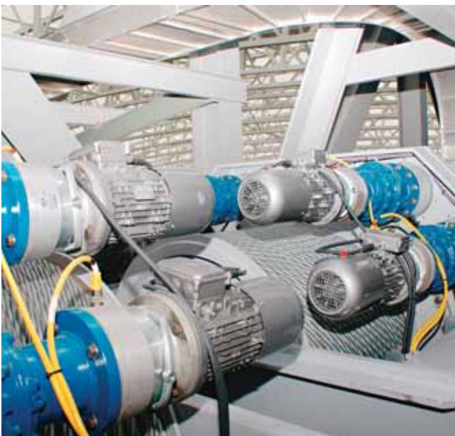
Obr.4: Pohony bubnových lanových navijakov na zdvíhanie video obrazovky (foto: Uni-Systems)
