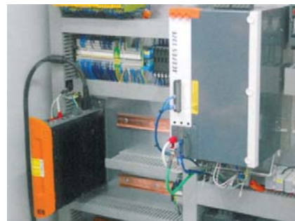
Obr.1: Servopohon ACOPOS je prepojený do riadiaceho poèítaèa APC620 cez zbernicu POWERLINK.
