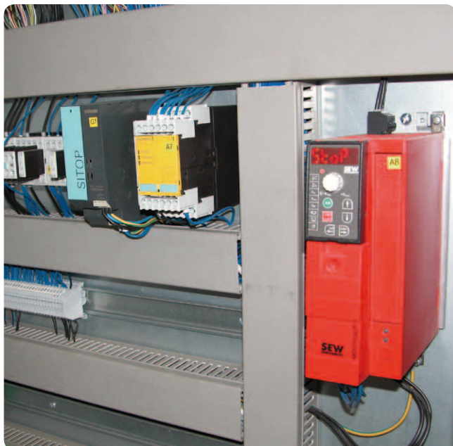
Obr. 2 0,75 kW frekvenčný menič riadi pohon na polohovanie montážneho rámu
