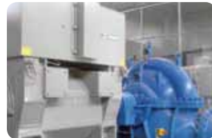
Obr. 3.: Pohony s meničmi zabezpečili v Madride ziskovú dodávku vody.
