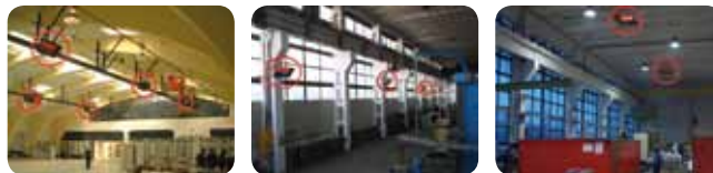
Obr. 5 Príklady umiestnenia infražiarčičov vo výrobných priestoroch (a, b, c)
