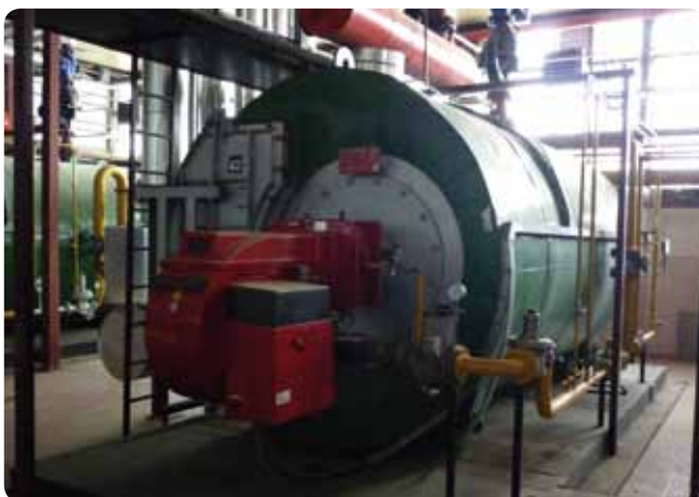
Obr. Plynový kotol v kotolni sídliska Juh
