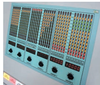
Zobrazenie polohy regulačných kaziet v blokovej dozorni
