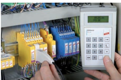
Kontrola jednotlivých modulov zvodiča Blitzductor
