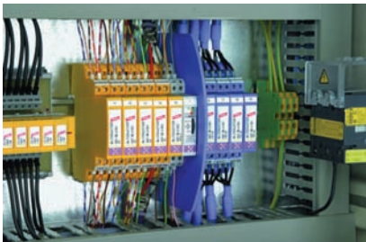
Zvodiče Blitzductor XT nainštalované v rozvádzači MaR
