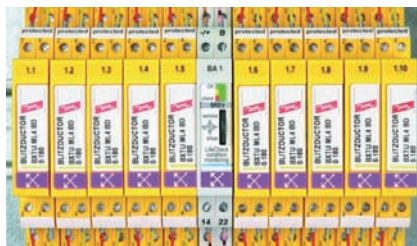
Nainštalované zvodiče Blitzductor s monitorovacou jednotkou DEHNrecord.
