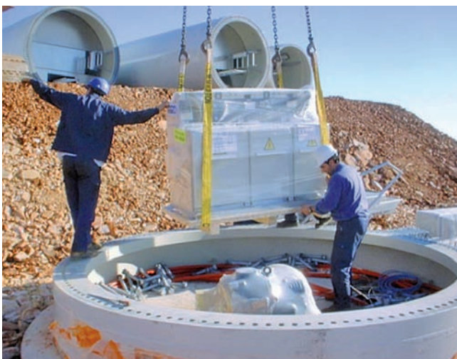
Obr. 7 Inštalácia kompaktného vn rozvádzača RM6 do stožiaru veternej turbíny (Schneider Electric, 2016)
