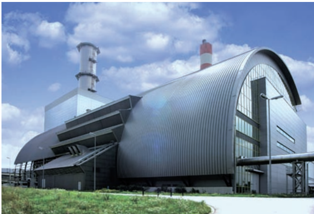
(Zdroj: Wien Energie)
