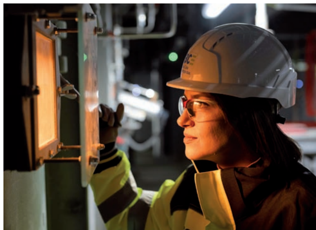
Slavica Mandić kontroluje pec. Zariadenie generuje dostatok tepelnej energie na vykurovanie 60 000 domácností v zime.
