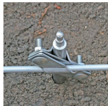
Nainštalovaný hĺbkový uzemňovač z nerezového materiálu V4A.
