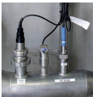
Snímače z radu Memosens Oxymax COS61D a Orbisint CPS11D merajú kyslík, resp. hodnoty pH priamo v SBR (v strede: tlakový spínač Ceraphant T PTC31).
