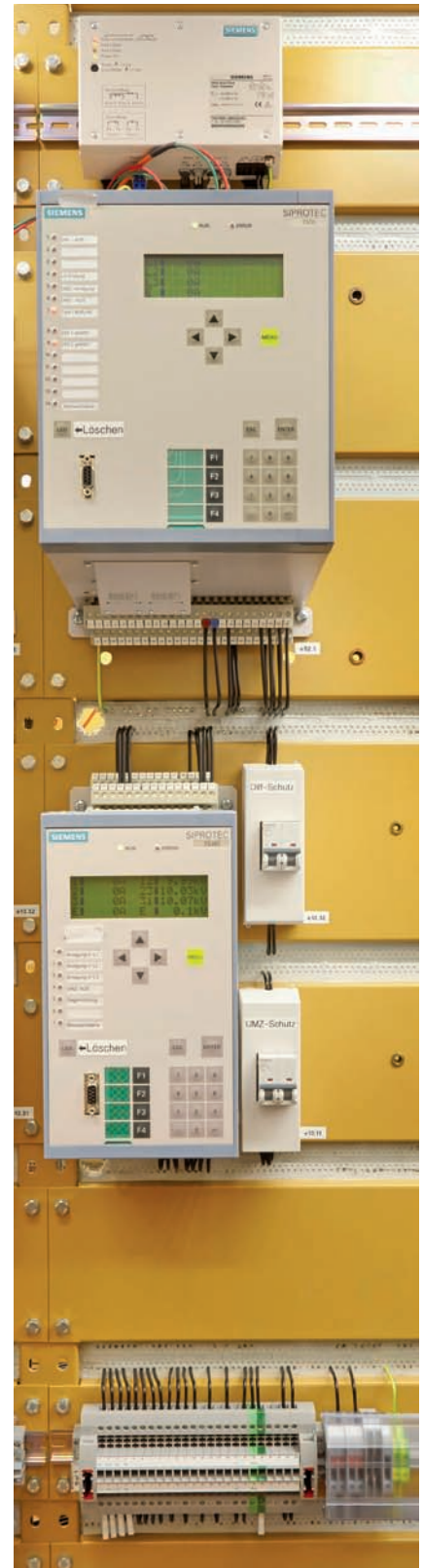
Obr. 3 Fame šetrí priestor pripojením hlavných a záložných bezpečnostných relé cez jeden testovací konektor – testovanie bezpečnosti sa následne vykonáva použitím rôznych nastavených testovacích konektorov.
