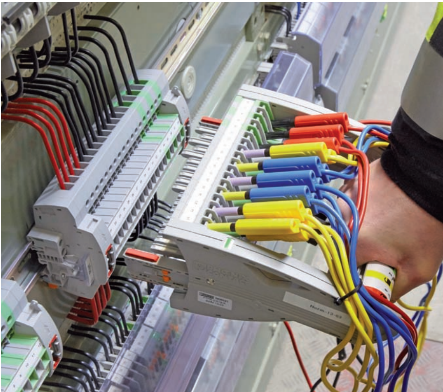
Obr. 2 Nové príležitosti pre trafostanice: Stadtwerke Mnichov modernizuje svoje spínacie stanice pomocou testovacieho systému Fame od Phoenix Contact.
