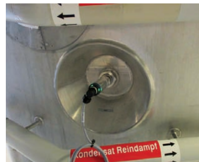
Zásobníková nádrž s inštalovaným senzorom iTHERM TrustSens
