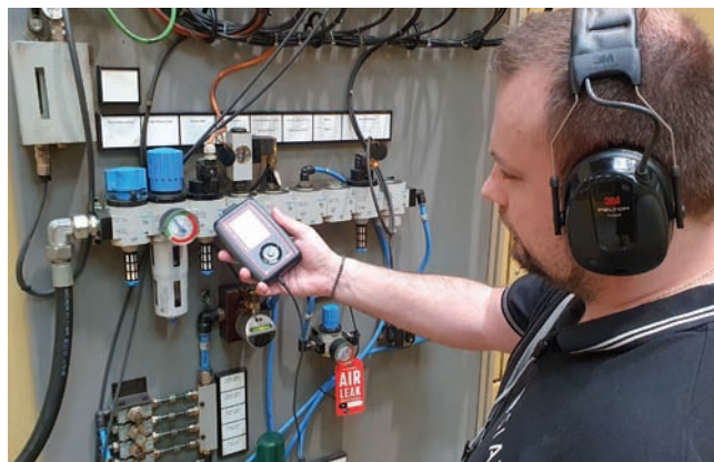
Meranie únikov s detektorom KRYPTON-PRO u zákazníka (viac obrázkov z použitia v praxi nájdete na www.atpjournalsk/39280 )
