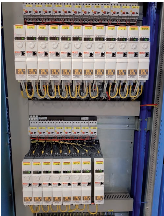
Riadenie pohybu zabezpečujú servozosilňovače a servomotory B&R.
