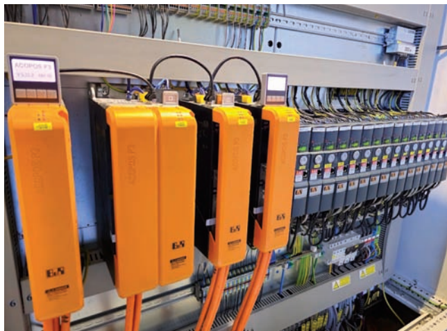
Chod dopravníkov je regulovaný pohonmi s inštalovanými frekvenčnými meničmi B&R.
