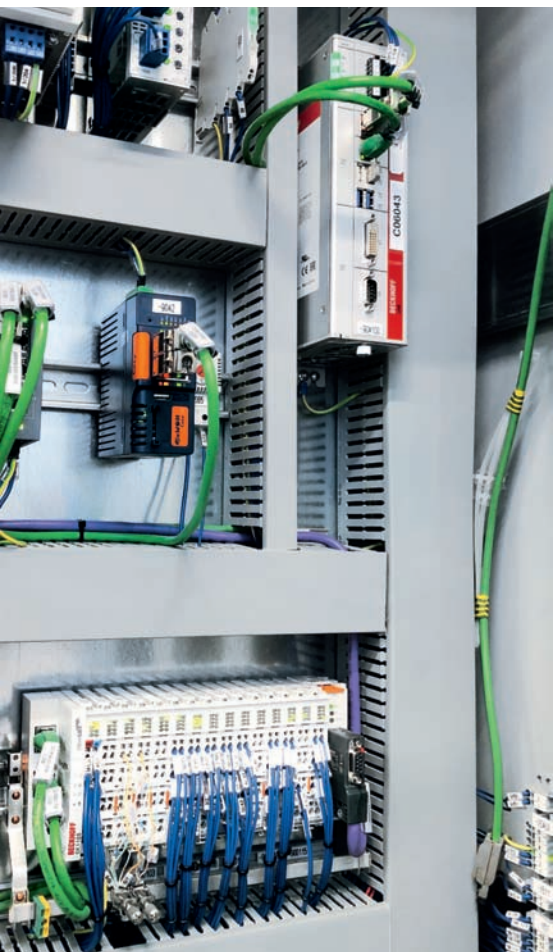
Jednotlivé procesy v lisovacích linkách Aida riadi priemyselné PC (vpravo hore) s riadiacim softvérom TwinCAT, ako aj rôznymi V/V svorkovnicami EtherCAT (dole) (Foto: Aida Engineering, Japonsko)
