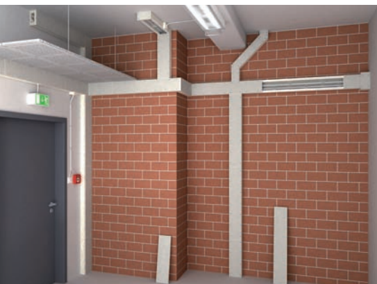
Protipožiarne kanál BSK nainštalovaný na stenu a strop
