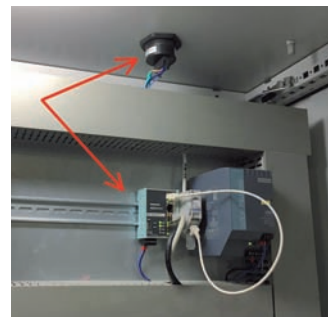
Vnútri rozvádzača: Wireless Bolt komunikuje so strojom cez ethernet (PROFINET).
