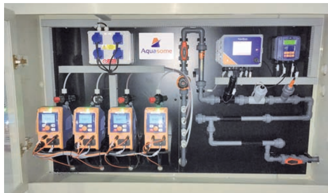
Pohľad na mozog modernej automatizovanej jednotky na úpravu chladiacej vody
