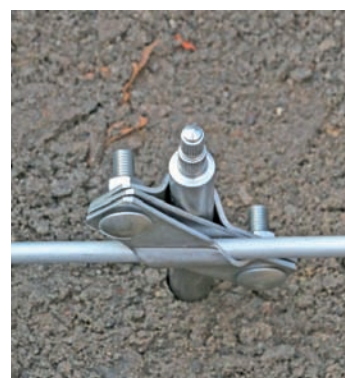
Nainštalovaný hĺbkový uzemňovač z nerezového materiálu V4A.
