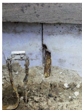
Poškodenie uzemňovača z pásoviny FeZn. Uloženie v zemi 5 rokov.
