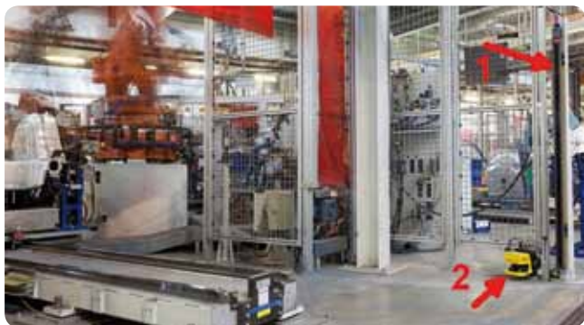
Obr. 2 Počas montáže podlahy v RCZ je robotická bunka s pohyblivým úchopným zariadením chránená z bokov bezpečnostnými svetelnými závorami COMPACTplus (1) a vertikálny a horizontálny priestor je chránený pomocou bezpečnostných laserových skenerov ROTOSCAN RS4 (2).
