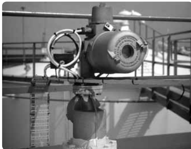
Obr. 12a Meranie pomocou snímača so servopohonom ako súčasť inštalácie HIMS
