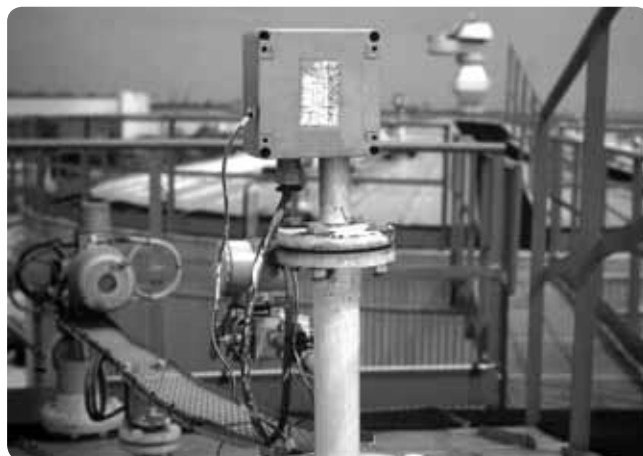
Obr. 12b Príklad snímača tlaku (inštalácia HIMS)
