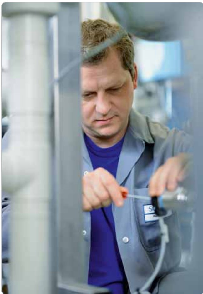
Obr. 2 Citlivá infraštruktúra: technik údržby René Zeidler kontroluje prístroje na meranie tlaku v prevádzke spracovania vody.
