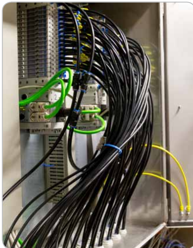
Obr. 2 Ventilové ostrovy Festo na Profinete
