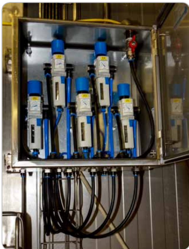
Obr. 1 Úprava vzduchu Festo pred vstupom do ventilových ostrovov
