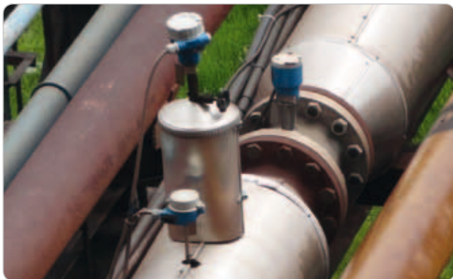
Obr. 2 Bežný systém merania pary pozostáva z kombinácie vírového prietokomera, vysielača tlaku a snímača teploty.
