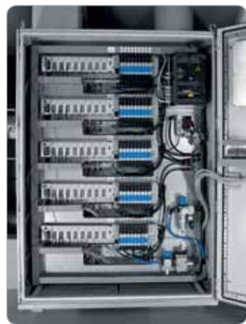
Obr. 1 Umiestnenie terminálu do rozvádzača
